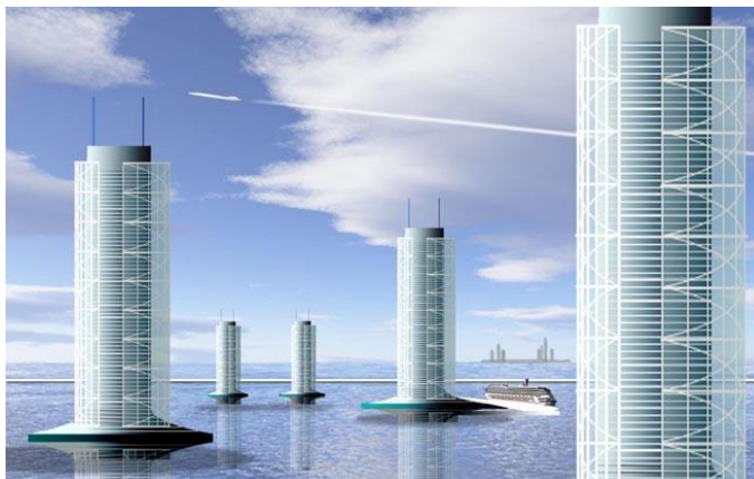
図 3-8 資源開発に特化したオー シャンランド (波浪の高い海域を航行するので セミサブ構造・半潜水構造となっ ています。)
